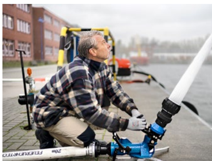
Löschmonitor. CPO schult seine Mitarbeiter an der reedereieigenen Brandschutzausrüstung.
