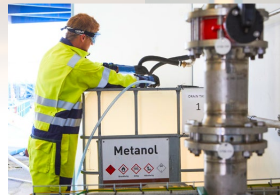
Expertise. Stena Line hat eine eigenständige Methanol-Versorgungsinfrastruktur aufgebaut.
